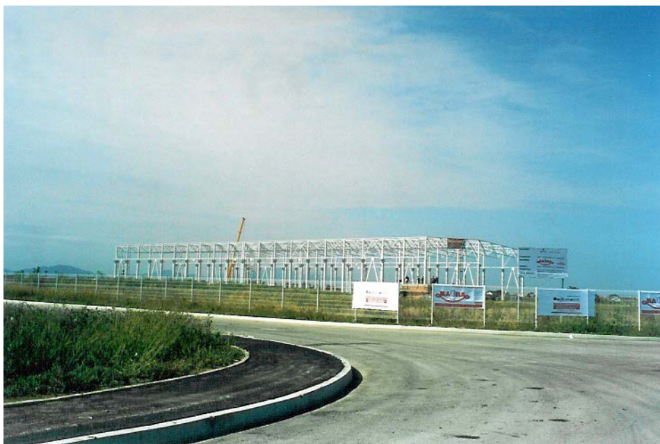
Gradilište tvrke “BHS”
